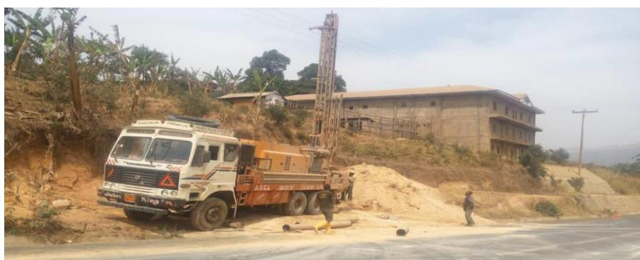
Bohren eines Bohrlochs im Berikids Center in Kumbo
